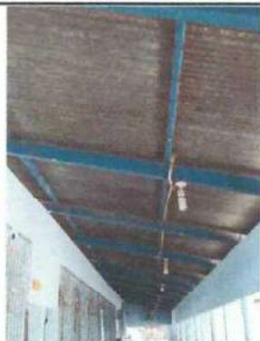
Foto1: Se observa la estructura que se va a pintar.
