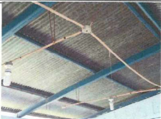
Foto1: Reparación del sistema eléctrico en tres aulas, dirección de primaria y dirección de INEB.
